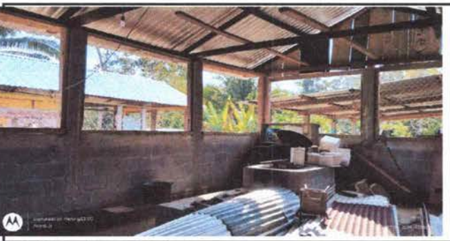
Foto 5: Repello y cambio de pila.
