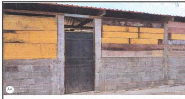
Foto 6: Instalacion de corredor, repello y piso.
