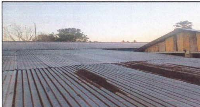
Foto 2: Cambio de techo por presentar filtraciones y deterioro de laminas.
