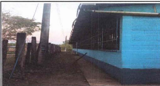
Foto1: Colocacion de corredor posterior en modulo 1.
