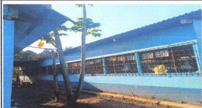
Foto 3: Instalacion de corredor y piso de cocina.
